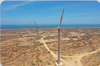
Parques Eólicos Jepírachi
